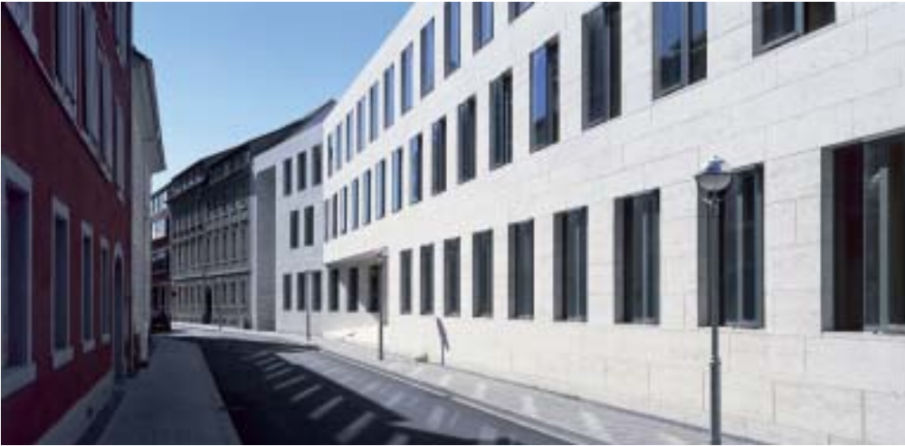
Links: Das neue Domizil des Bundesgerichtshofs nimmt die Maßstäbe der Umgebung auf. Rechts: Hinter den geschlossenen Steinfassaden zum Senatshof – sie sollen Assoziationen an Buchrücken wecken – verbergen sich die Magazine der Bibliothek.
